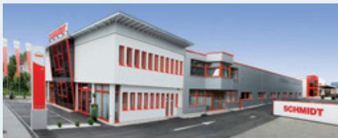
Schmidt Zentrale in Ried im Innkreis nach den Neu- bzw. Umbauarbeiten 2010
